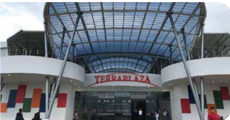
Centro Comercial Terraplaza
